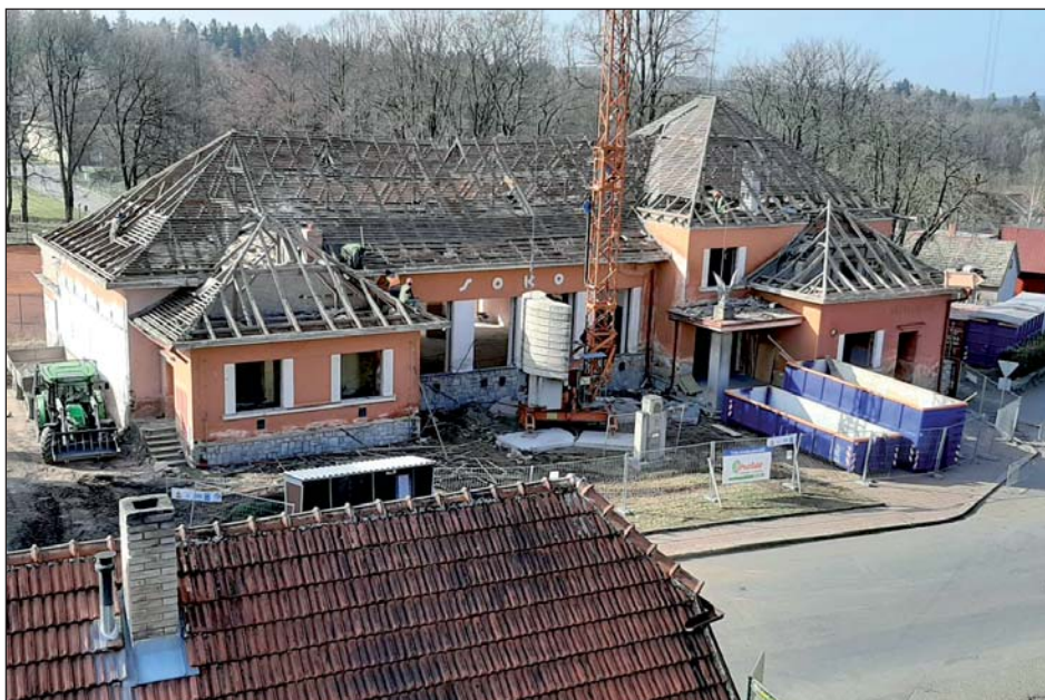
Rekonstrukce černovické sokolovny
