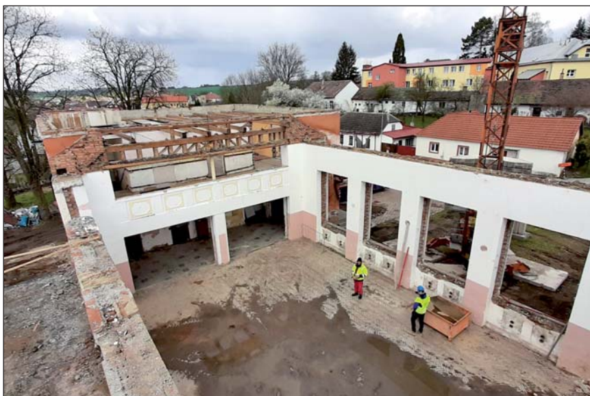
Další pohled na rekonstruovanou sokolovnu.
