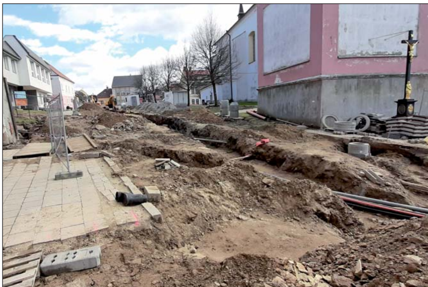
Rekonstrukce černovického náměstí.
