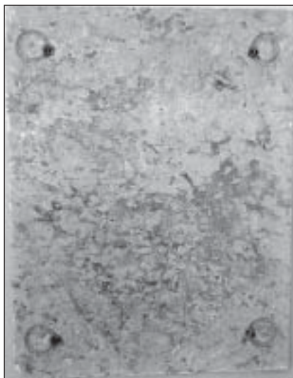
Obr. 1. Z pravé strany bočního vchodu. Žulový, zcela setřený a nečitelný. Podle kovových kruhů v rozích by se mohlo jednat o krycí desku ke vstupu do hrobky.
