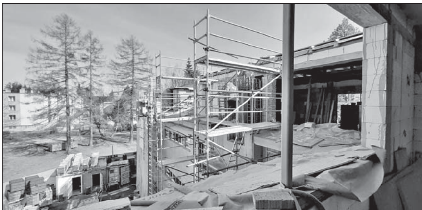
Výhled z okna nového kabinetu směrem k Tyršově ulici. Za lešením roste výtahová šachta.
