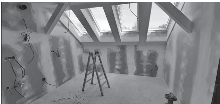
V podkrovním bytě už jsou namontované sádrokartony.
