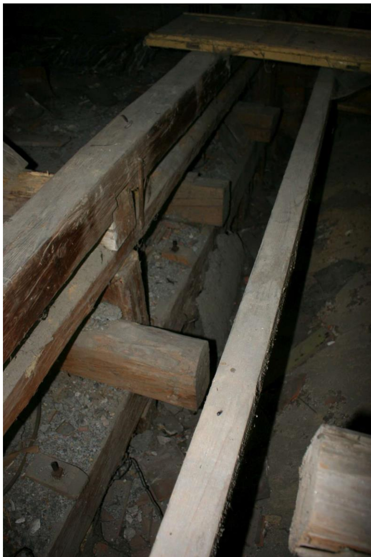
Obr. 5 – Dřevěné trámy nadpraží galerie balkónu
